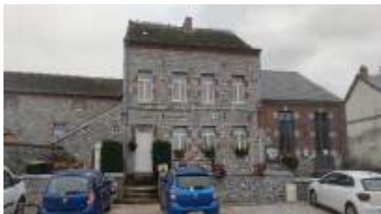
La maison à rénover est au centre de la photo
